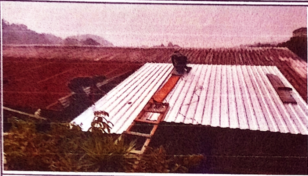
Foto 1: Reparación de cubierta de lamina a troqueladas
