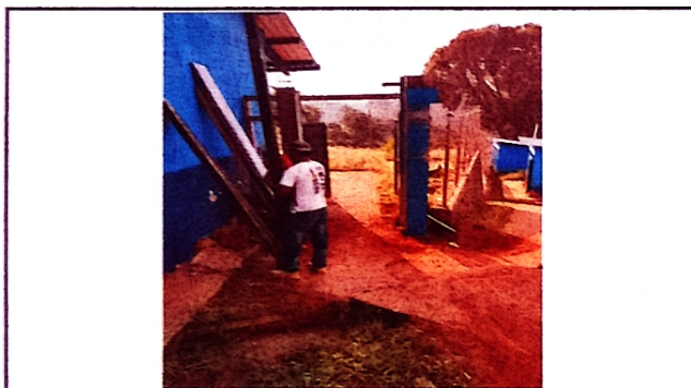
Foto 9: Reparacion de portones
