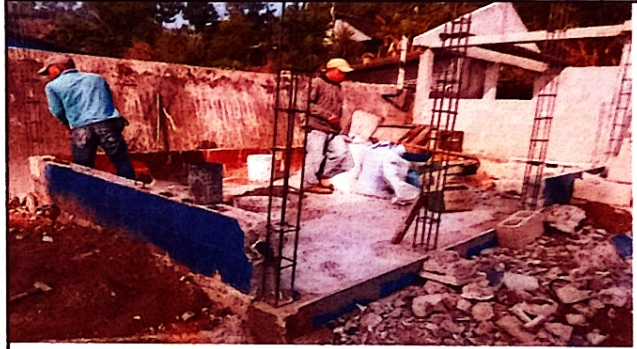
Foto 16: Reparación de pared de cocina.
