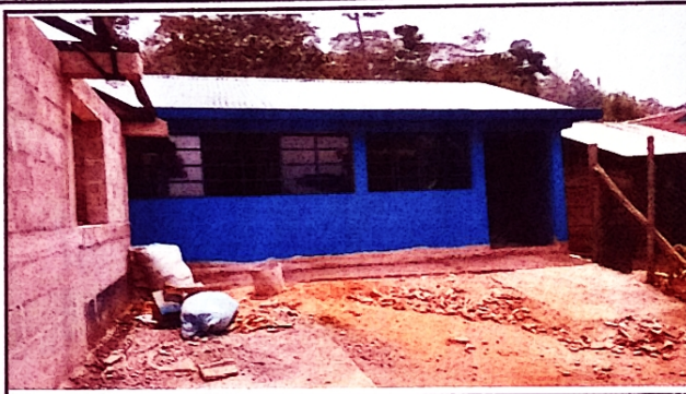
Foto 8: Sustritucion de canales pluviales
