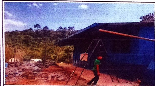
FOTO 5: Sustitucion de canales pliviales.
