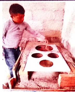
Foto 14 sustitucion de estufa rural
