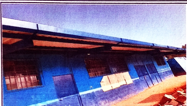
Foto 7: Sustritucion de canales pluviales
