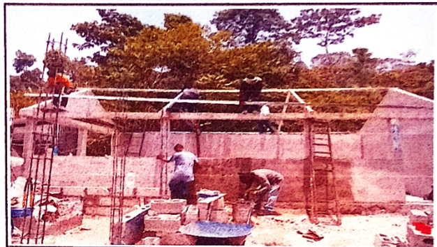
Foto 2: Susustitucion de lamina sobre el aula de cuarto, quinto y sexto primaria
