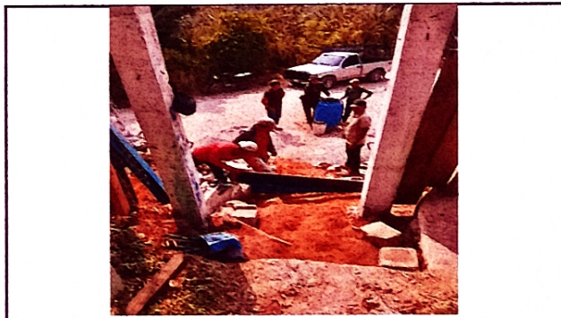
Foto 10: Reparacion de portones
