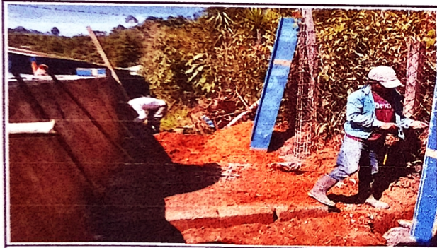
foto 3: susticion de base para tinaco
