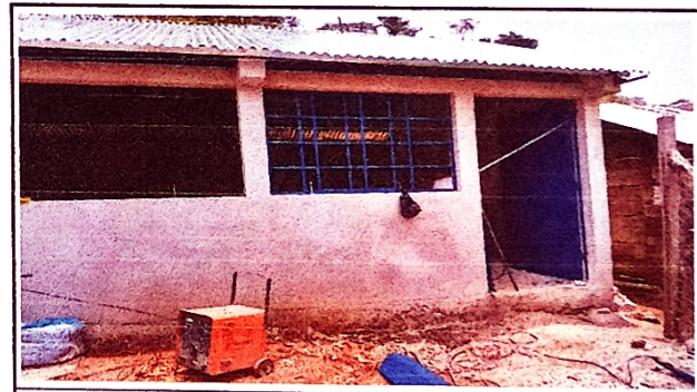
Foto 4: Susustitucion de puerta principal del aula de primero, segundo y tercero primaria
