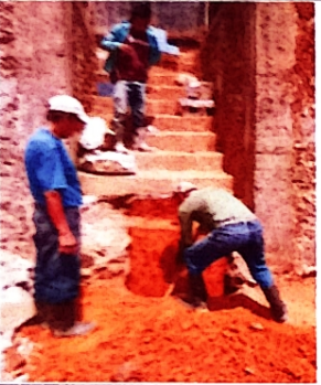
Foto 15 reparación de muro de contención
